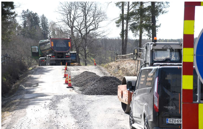
Kosken asemalla on tuskailtu Koskenkartanontien surkeaa kuntoa jo vuosia. Nyt kunnostustyöt ovat käynnissä. Kuva on tiistailta.
